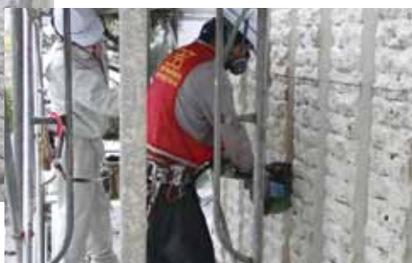
2号棟 エアーカッターでの施工
