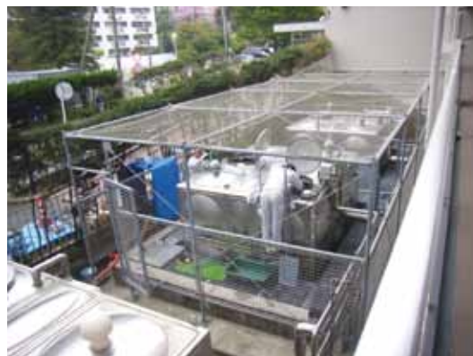
3号棟 消波対策工事 1
