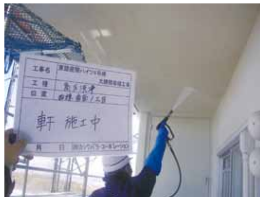
4号棟 大規模修繕工事 2
