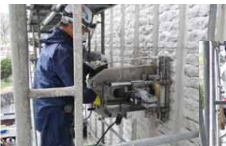
2号棟 ウォールソーでの施工
