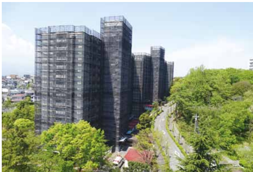
4号棟 大規模修繕工事 1
