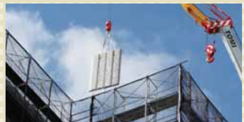
2号棟鉄骨階段袖壁撤去工事 (本文2ページ参照)
