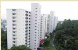
4号棟大規模 修繕工事竣工 (本文3ページ参照)
